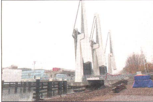
De geheel vernieuwde Bosrandbrug staat nu nog dicht. (Foto: Rob Joore)
