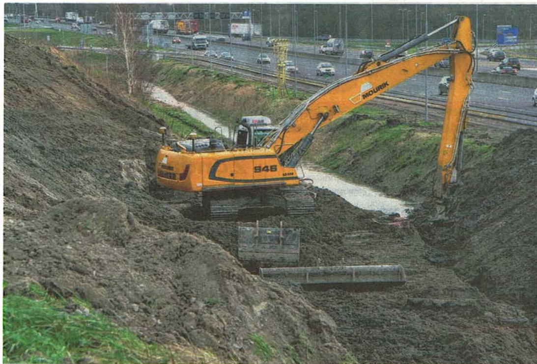
■ Een eerste onderzoek zou aantonen dat de graafwerkzaamheden bij de A9 geen milieurisico vormen.
