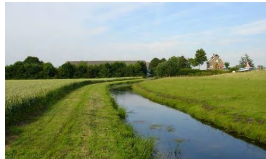
Voetsloot onder aan de dijk
