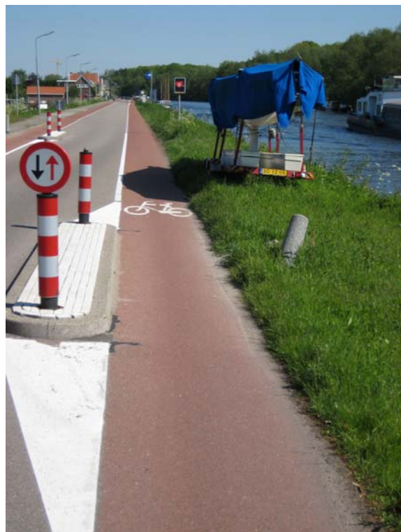
Betonnen paaltje ter blokkering van onjuist passeren staat scheef
