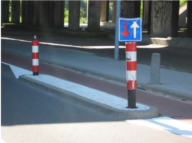
Bord en markering zwaar beschadigd thv A4 viaducten Sinds 31 december 2008
