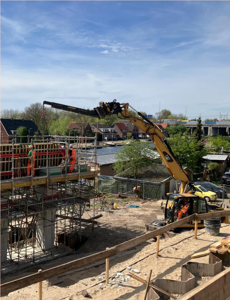
Het maken van de onderslagbalken aan de Oude Haagseweg in Amsterdam
